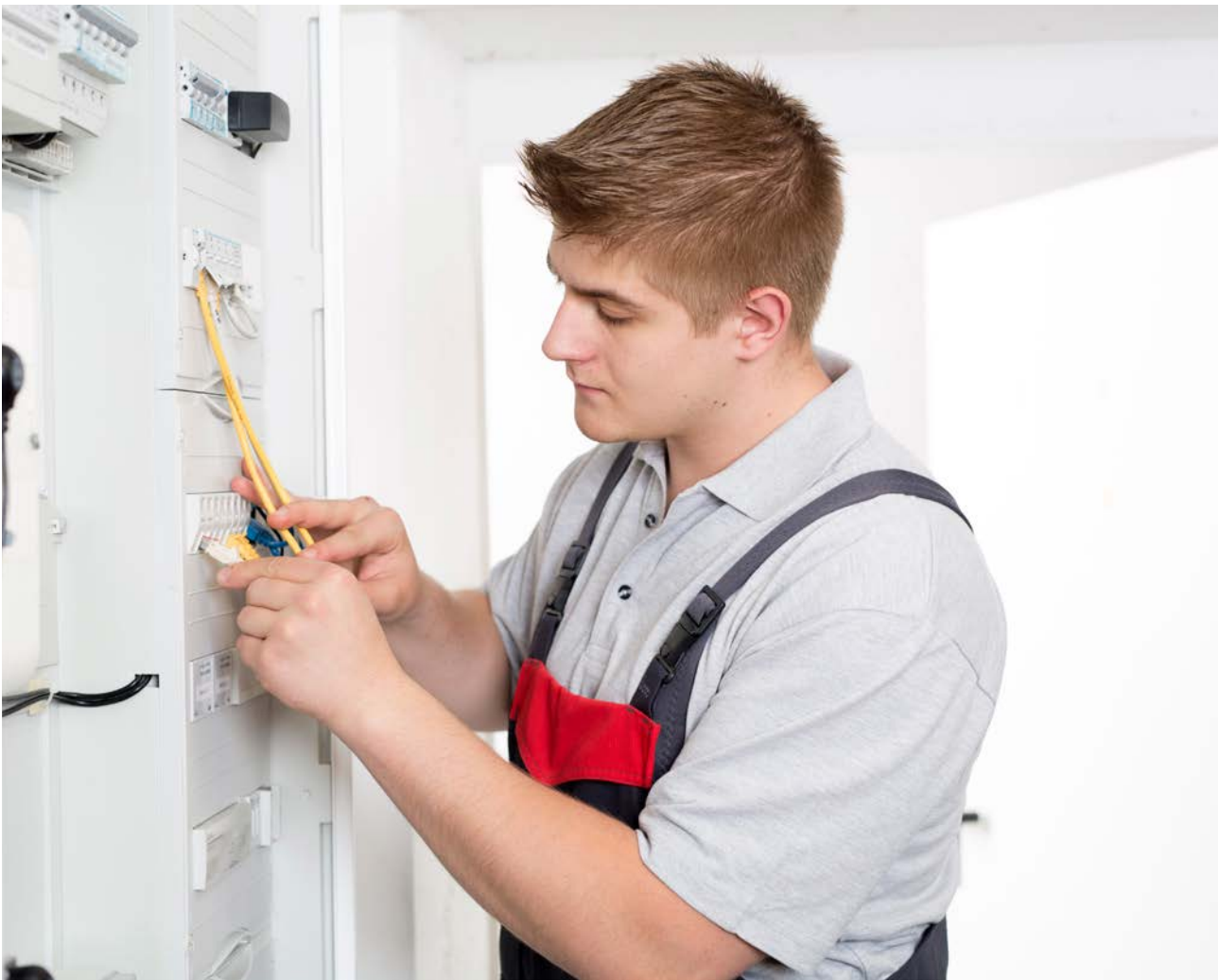
Abbildung 5: Überprüfen des Schaltschranks (Quelle: ZVEH)
